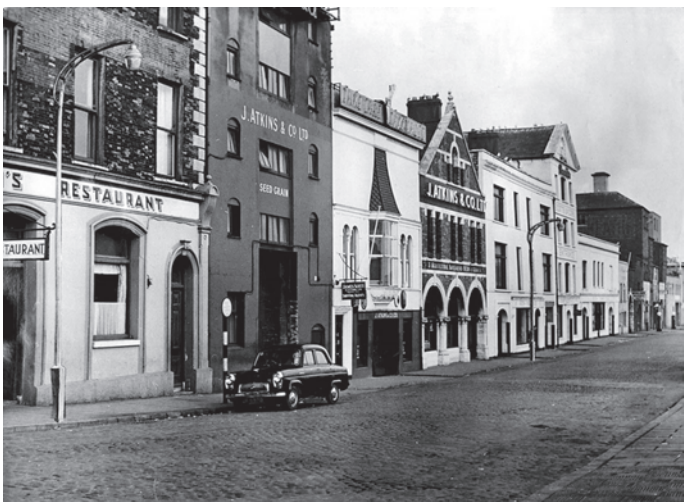
Straßenbeleuchtung in Cork, 1960, St Patrick's Quay
